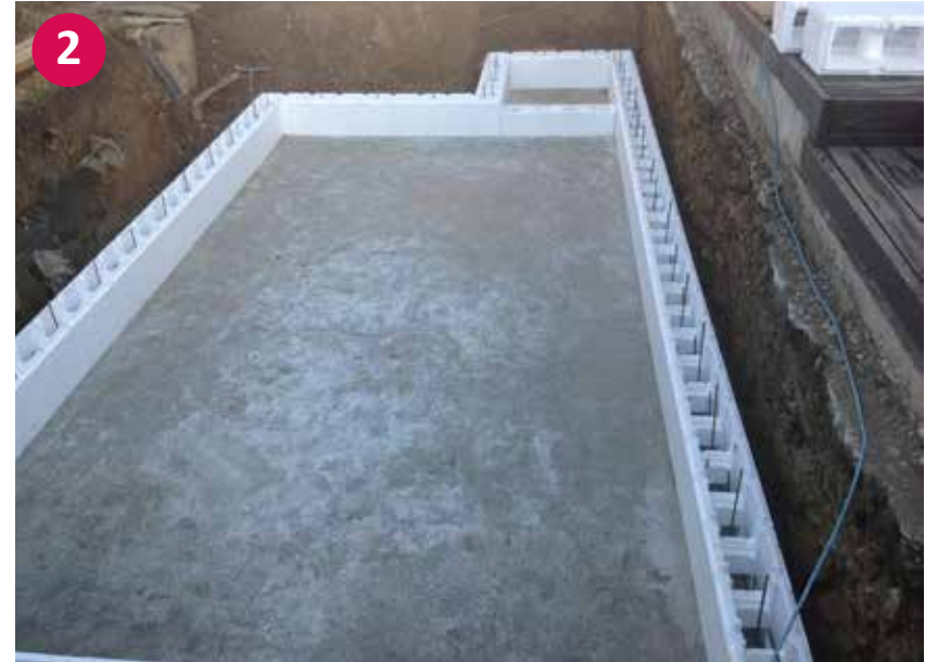
▲ Ansätzen der ersten Reihe Styropor Steine
