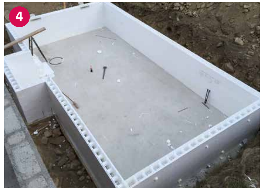
▲ Fertig aufgestelltes Styropor Becken – ohne Betonfüllung
