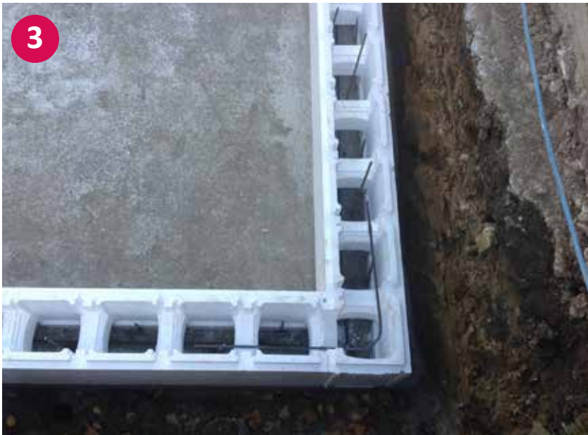
▲ Detailbild einer Eckverbindung samt Eisenarmierung
