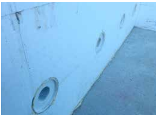
▲ Fertig eingeschäumte Wanddurchführung
