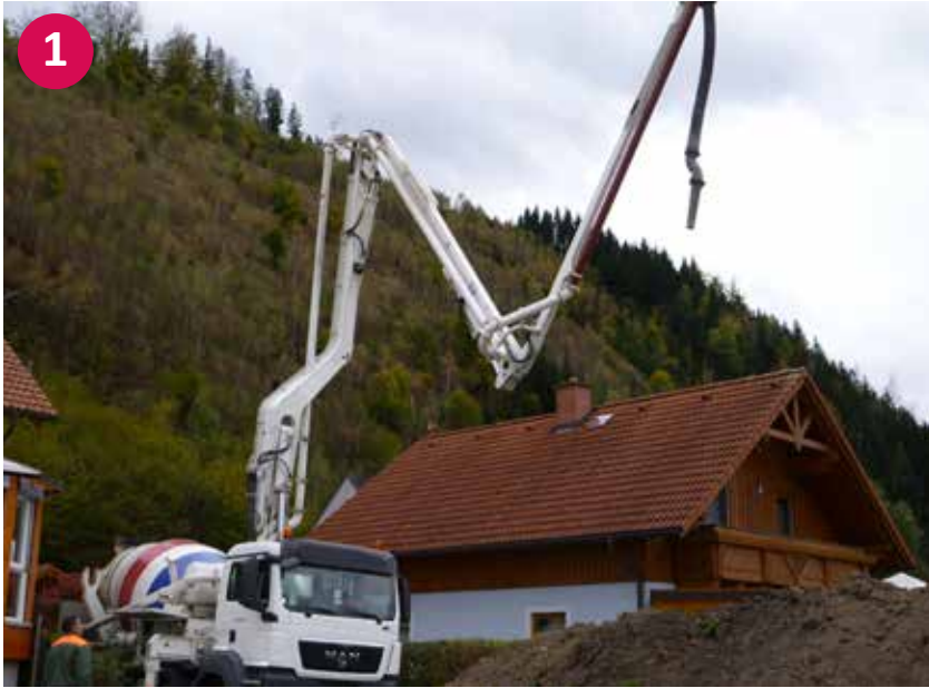
▲ Betonwagen mit Betonpumpe und Fallbremse
