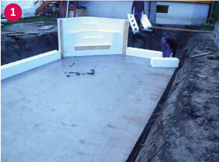
▲ Ecktreppe mit erster Ansatzreihe Styroporsteine
