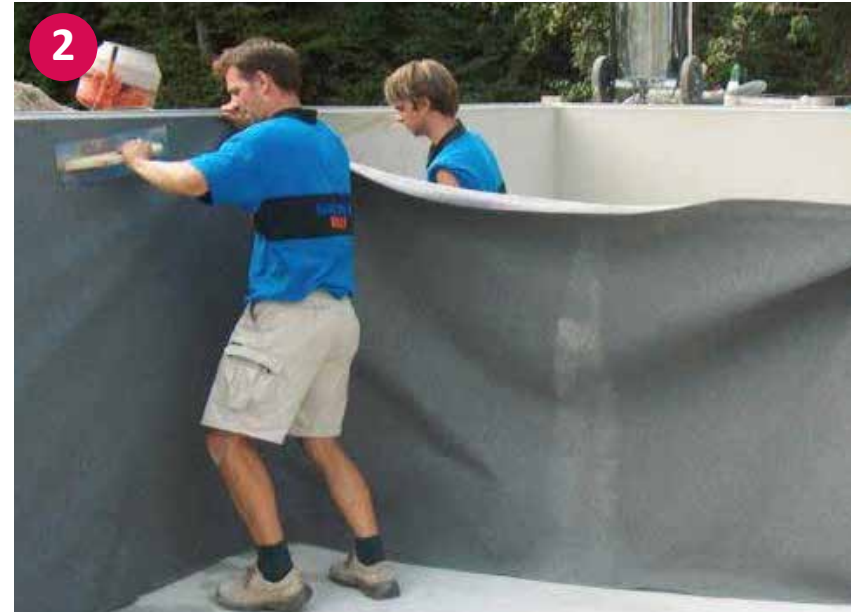
▲ Punktuelle Befestigung der Vliestrennlage mittels Styroporkleber
