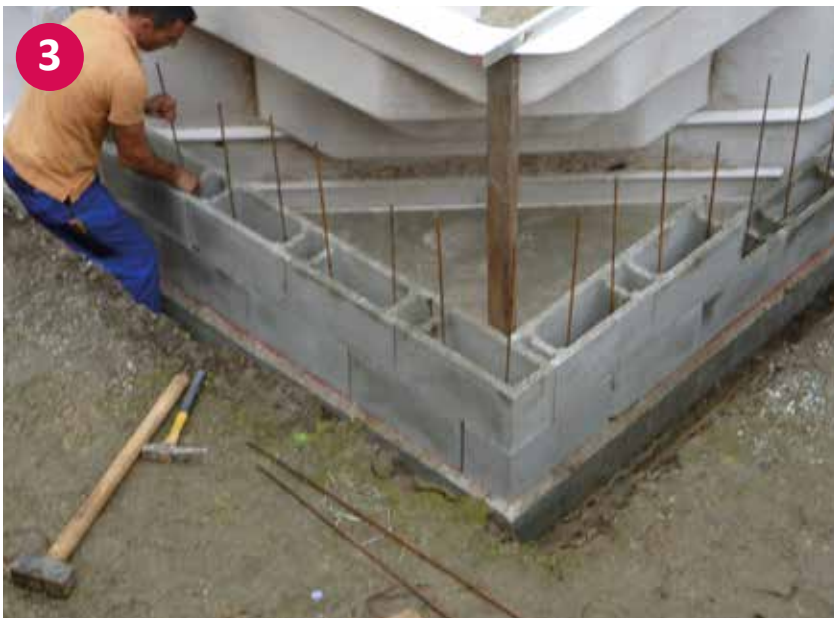
▲ Untermauerung der Ecktreppe
