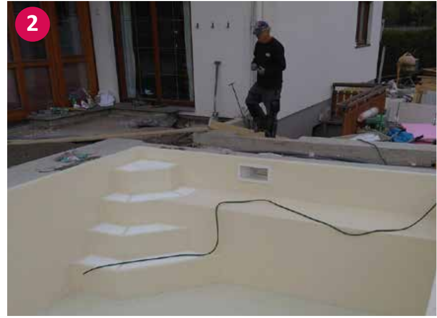
▲ Upper Class Trapezterre mit Sitzbankadapter rechts und 1,5mm Folienauskleidung (Sand)
