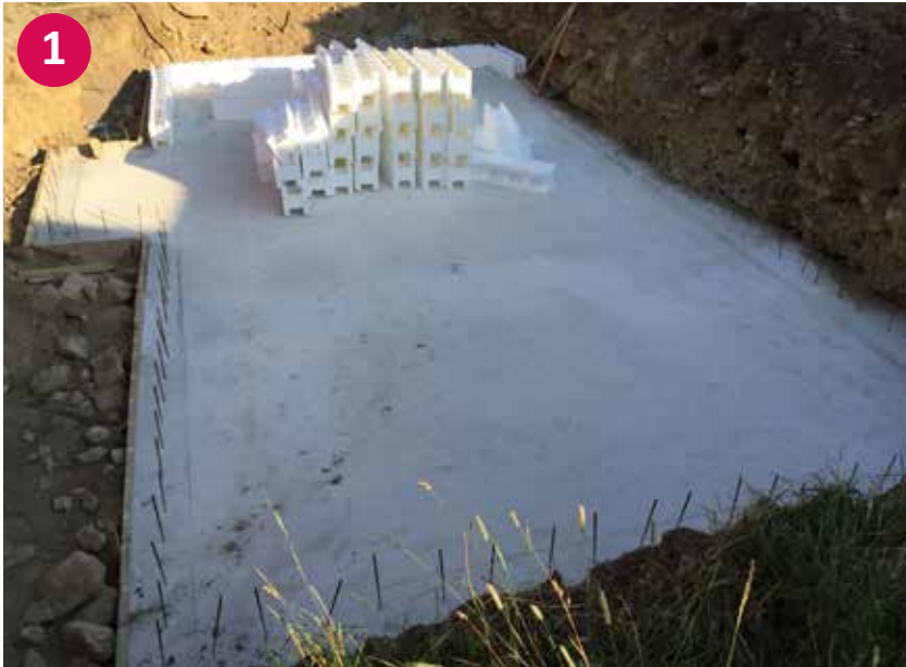
▲ Fertig ausgehärtete Bodenplatte
