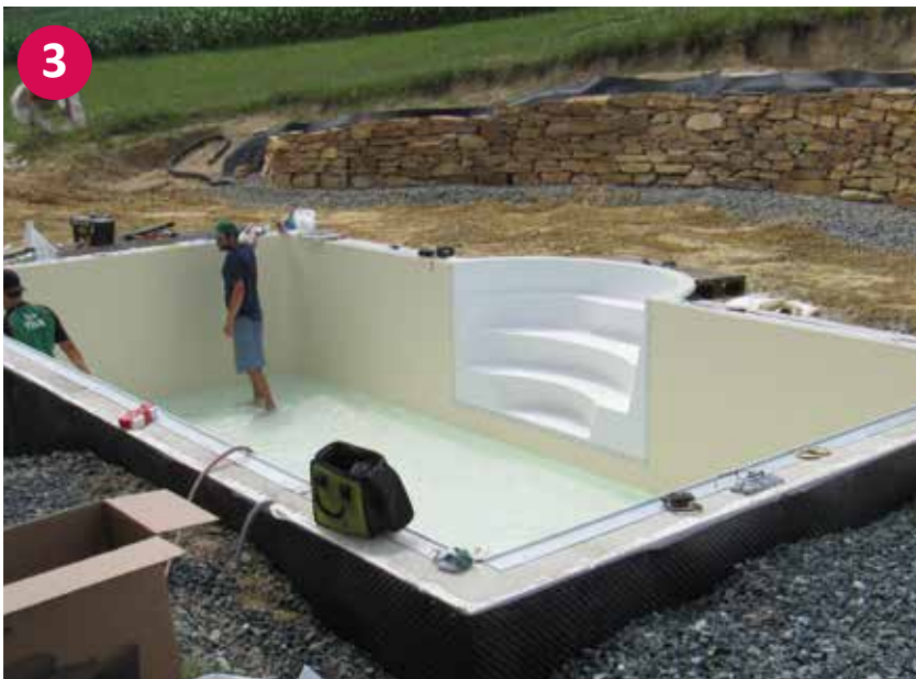
▲ Einhängen des Foliensacks und Anflanschen der Einbauteile
