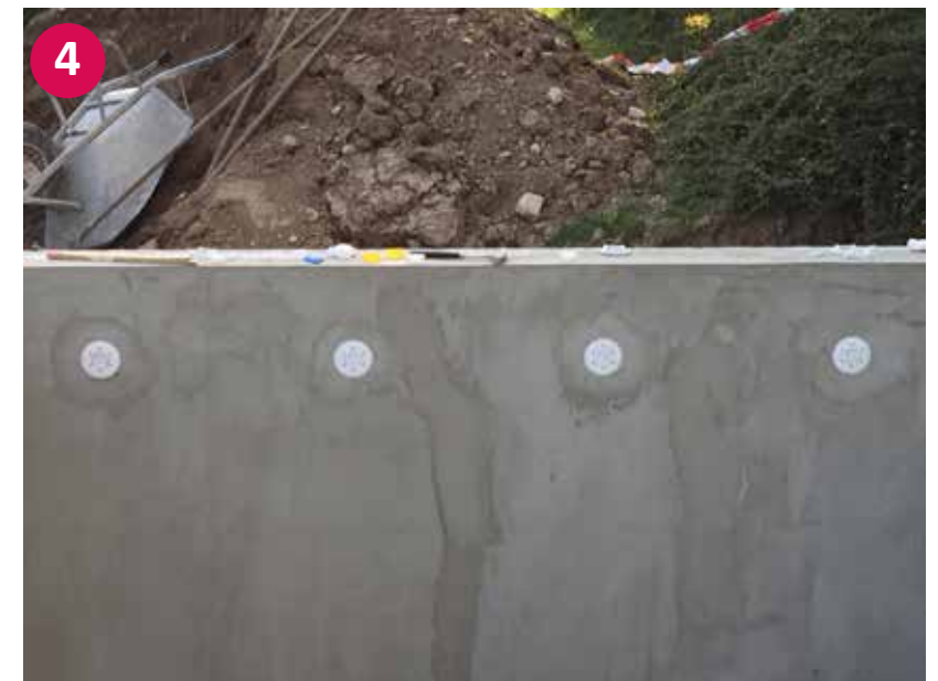
▲ Wichtig: Abdrücken der Rohrleitungen!
