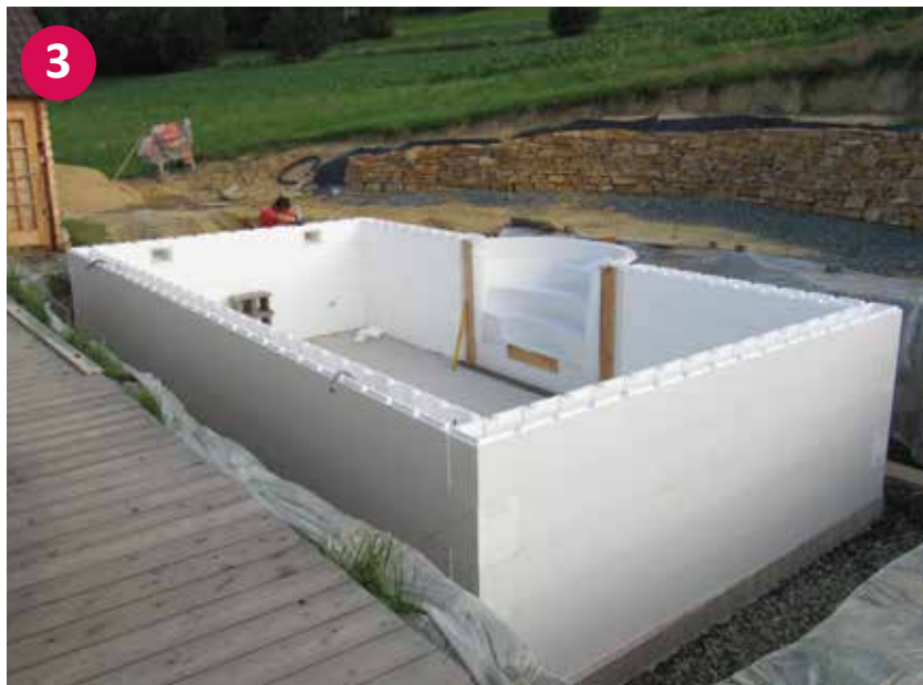
▲ Aufgestelltes Styroporstein Becken mit Römertreppe – ohne Betonfüllung
