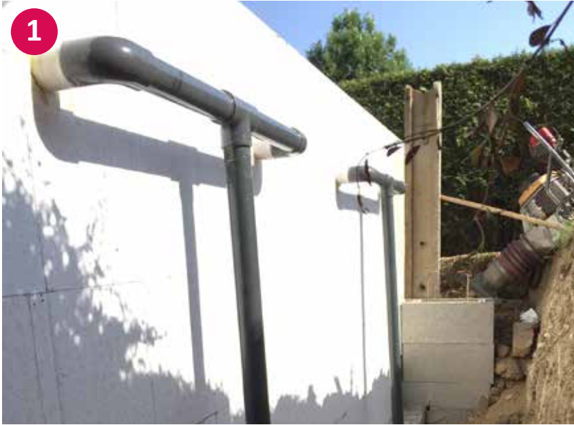
▲ Verrohrung von 4-Düsen
