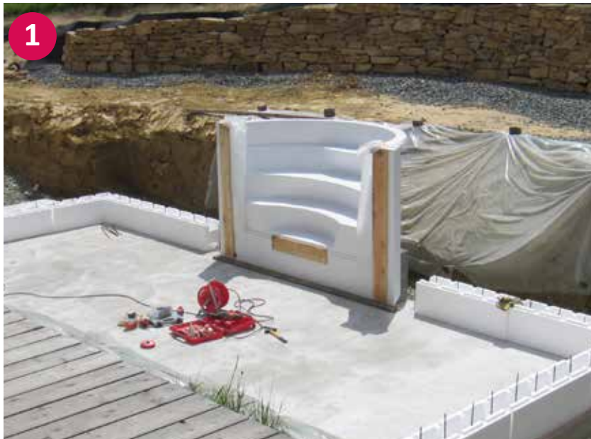
▲ Römertreppe mit erster Ansatzreihe Styroporsteine
