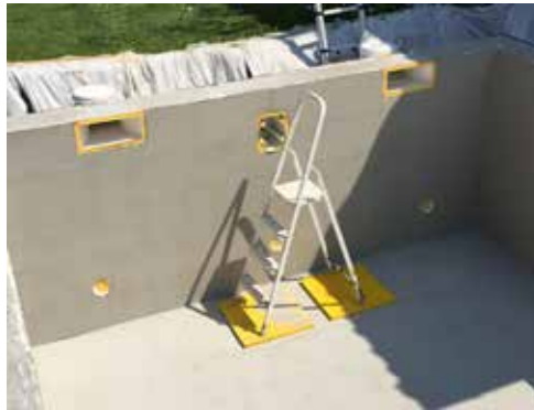
▲ Fertig verspachtelte Innenwand
