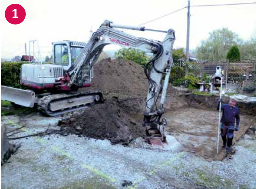
▲ Aushub der Baugrube
