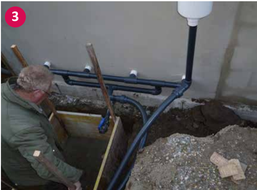
▲ Verrohrung von Düsen, Skimmer und Bodenablauf
