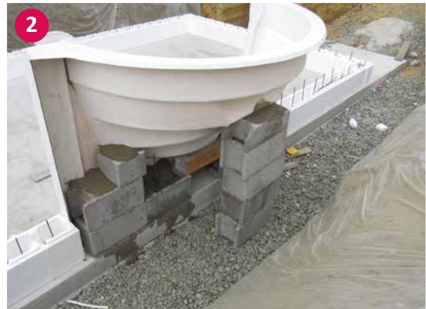
▲ Untermauerung der Römertreppe
