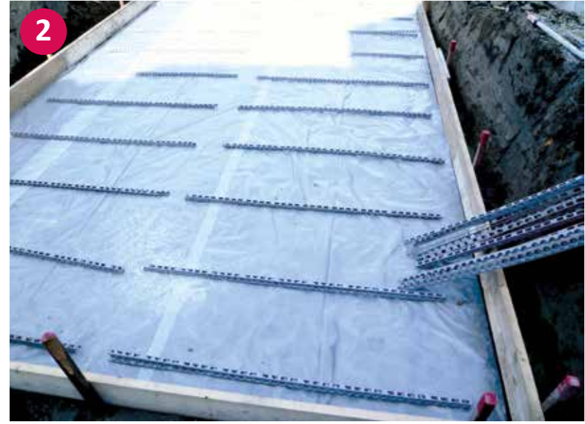
▲ Abschallung der Bodenplatte
