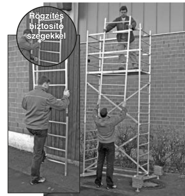
Alapállvány első és második magasítással
