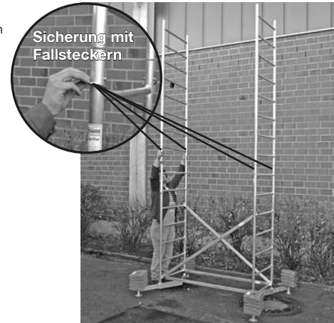
Grundgerüst mit erster und zweiter Aufstockung
