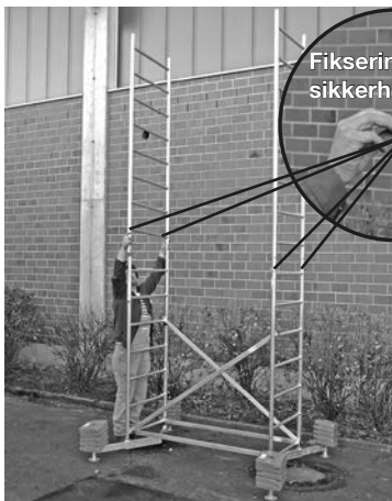
Grundmodul med første og anden tilbygning
