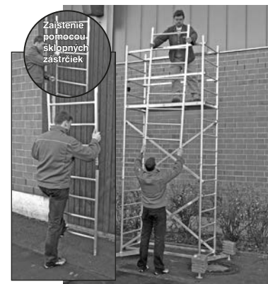
Základné lešenie s prvou a druhou nadstavbou
