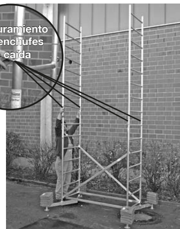
Andamio básico con primero y segundo piso
