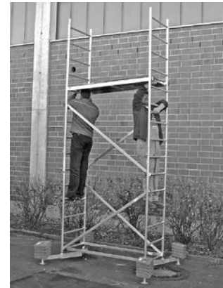
Perustelineet kahdella lisäkerroksella
