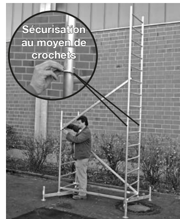
Échafaudage de base avec première rehausse
