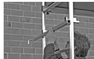
Grunnstillas med første tilbygg
