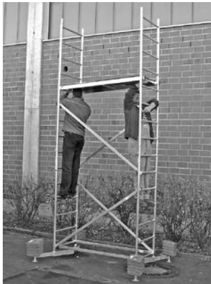
Grundgerüst mit erster und zweiter Aufstockung
