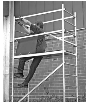
Basissteiger met eerste slag
