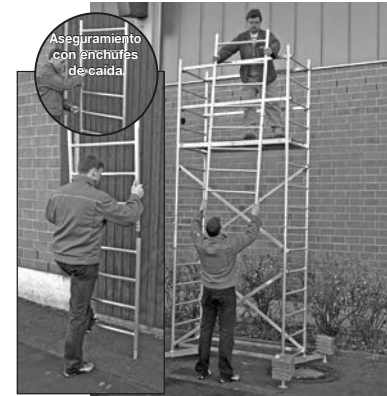
Andamio básico con primero y segundo piso
