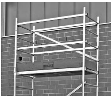
Échafaudage de base avec première rehausse
