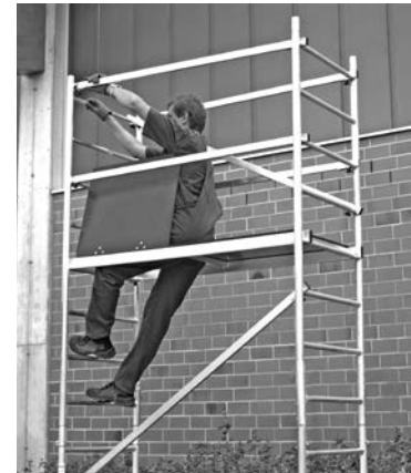
Grundgerüst mit erster Aufstockung
