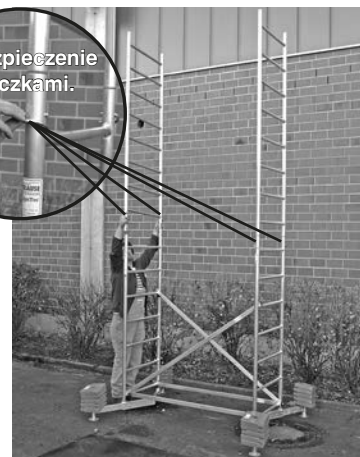
4 Podstawa rusztowania z pierwszą i drugą kondygnacją
