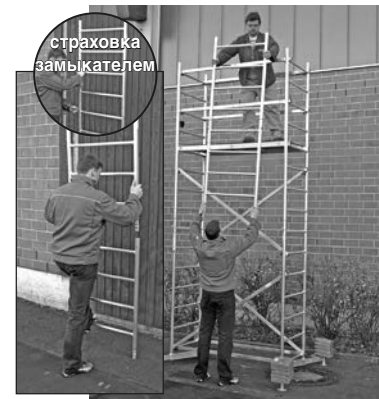
Базовая конструкция с первой и второй надстройками
