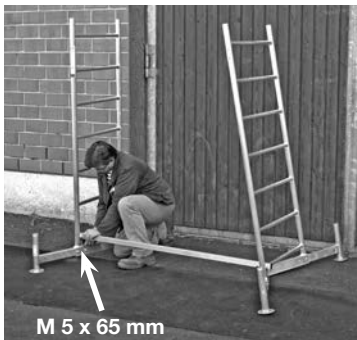
Podstawa rusztowania z pierwszą kondygnacją.
