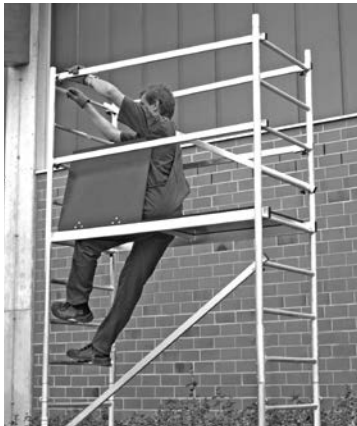
Perustelineet yhdellä lisäkerroksella
