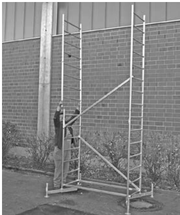
Grundgerüst mit erster Aufstockung
