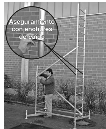
Andamio básico con primer piso
