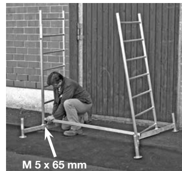
Grunnstillas med første tilbygg
