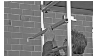
Perustelineet yhdellä lisäkerroksella
