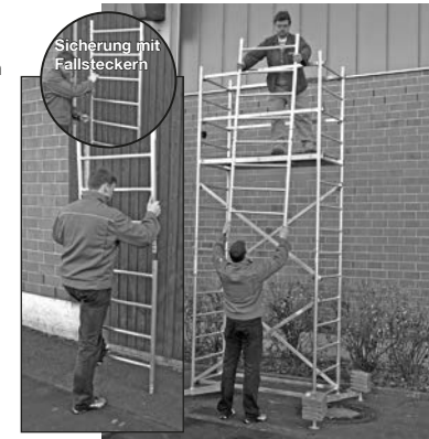
Grundgerüst mit erster und zweiter Aufstockung
