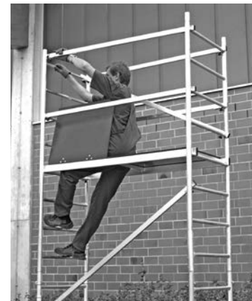
Échafaudage de base avec première rehausse
