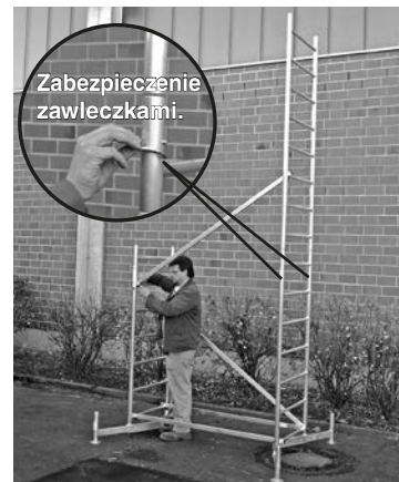
Podstawa rusztowania z pierwszą kondygnacją.
