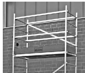
Grunnstillas med første tilbygg
