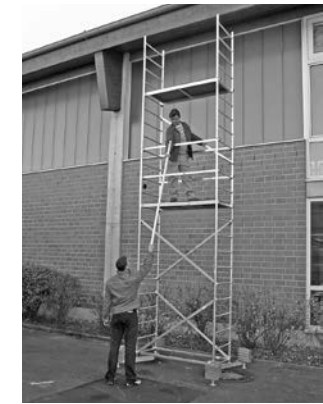
Perustelineet kahdella lisäkerroksella
