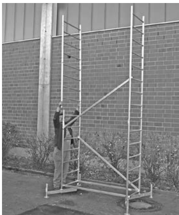
Échafaudage de base avec première rehausse
