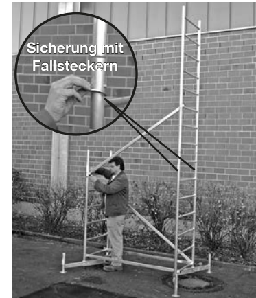
Grundgerüst mit erster Aufstockung
