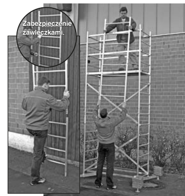
4 Podstawa rusztowania z pierwszą i drugą kondygnacją
