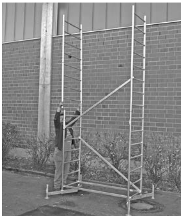
Basissteiger met eerste slag
