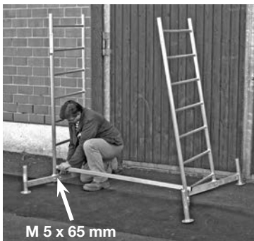
Andamio básico con primer piso
