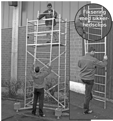
Grundmodul med første og anden tilbygning
