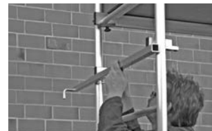
Grundmodul med første og anden tilbygning
