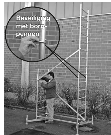
Basissteiger met eerste slag
