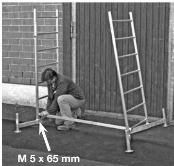
Échafaudage de base avec première rehausse
